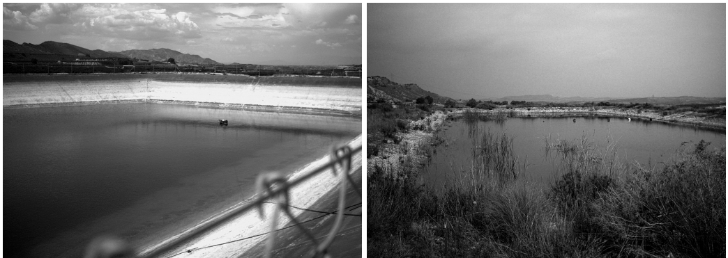
Figura 4. Ejemplos de balsas de riego de Polietileno de Baja Densidad (derecha) y de Polietileno de Alta Densidad (izquierda).
